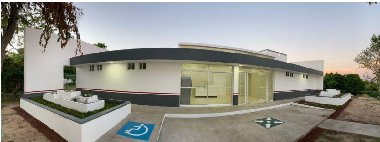
Construcción de un centro de salud en la localidad Morales Cabo Rojo, Municipio de Tampico Alto
