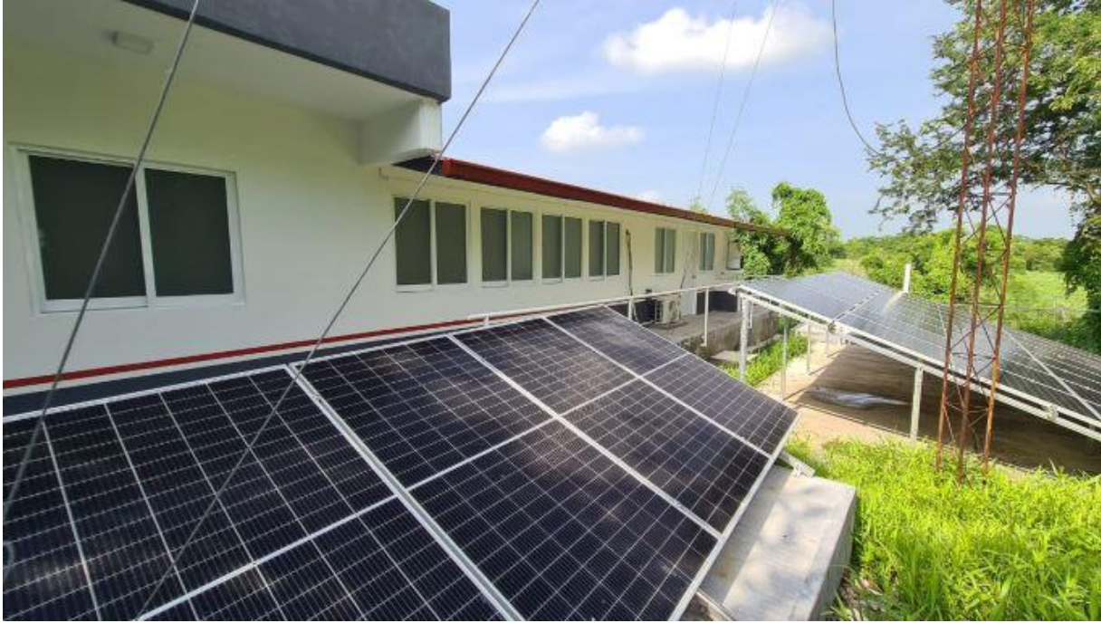
Rehabilitación de un centro de salud con paneles solares en la localidad de Tamarindo de San Miguel municipio de Soledad de Doblado
