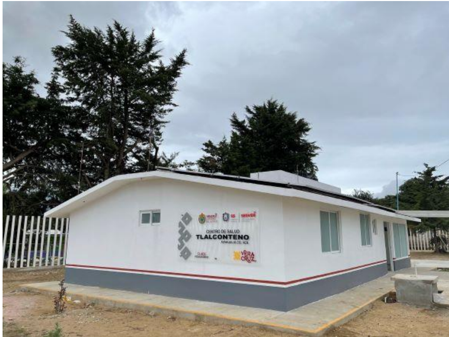
Mantenimiento de un centro de salud con paneles solares en la localidad de Tlalconteno municipio de Ayahualulco
