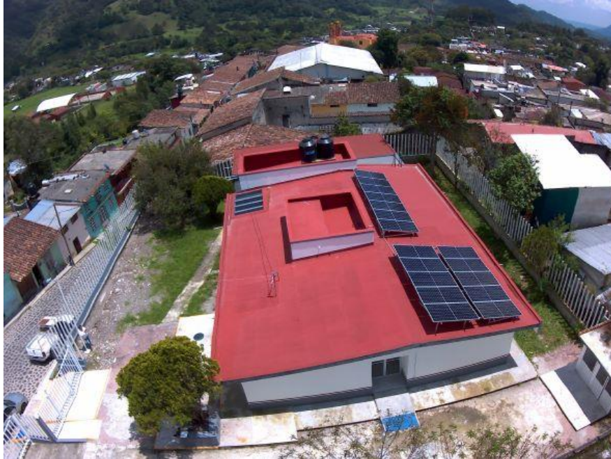
Mantenimiento de un centro de salud con paneles solares en la localidad y municipio de Ixhuacán de los Reyes
