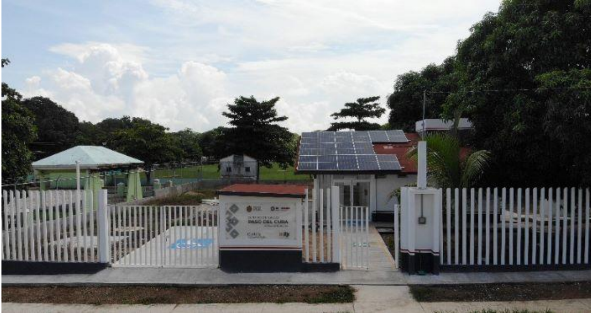
Mantenimiento de un centro de salud con paneles solares en la localidad de Paso del Cura municipio de Chacaltianguis
