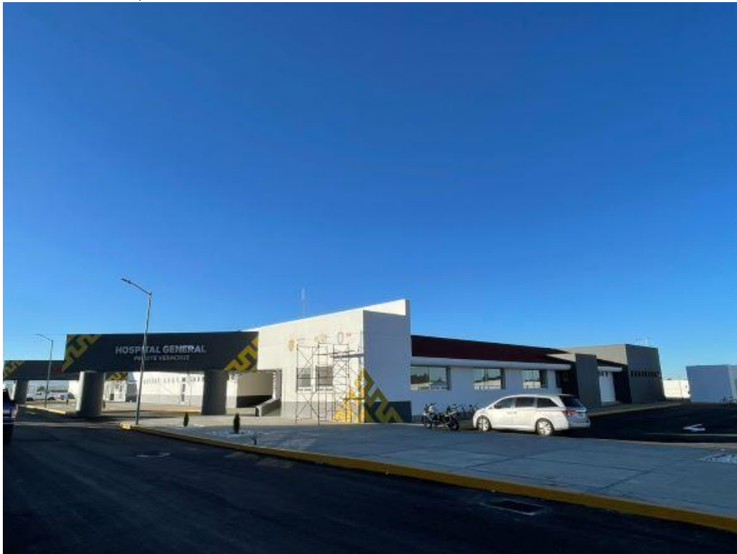
Terminación del Hospital General de Perote tras abandono de 8 años
