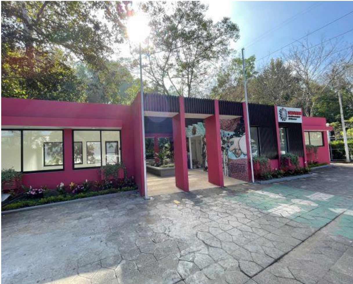
Rehabilitación del Centro de Estudio e Investigación de Medicina Tradicional de Veracruz
