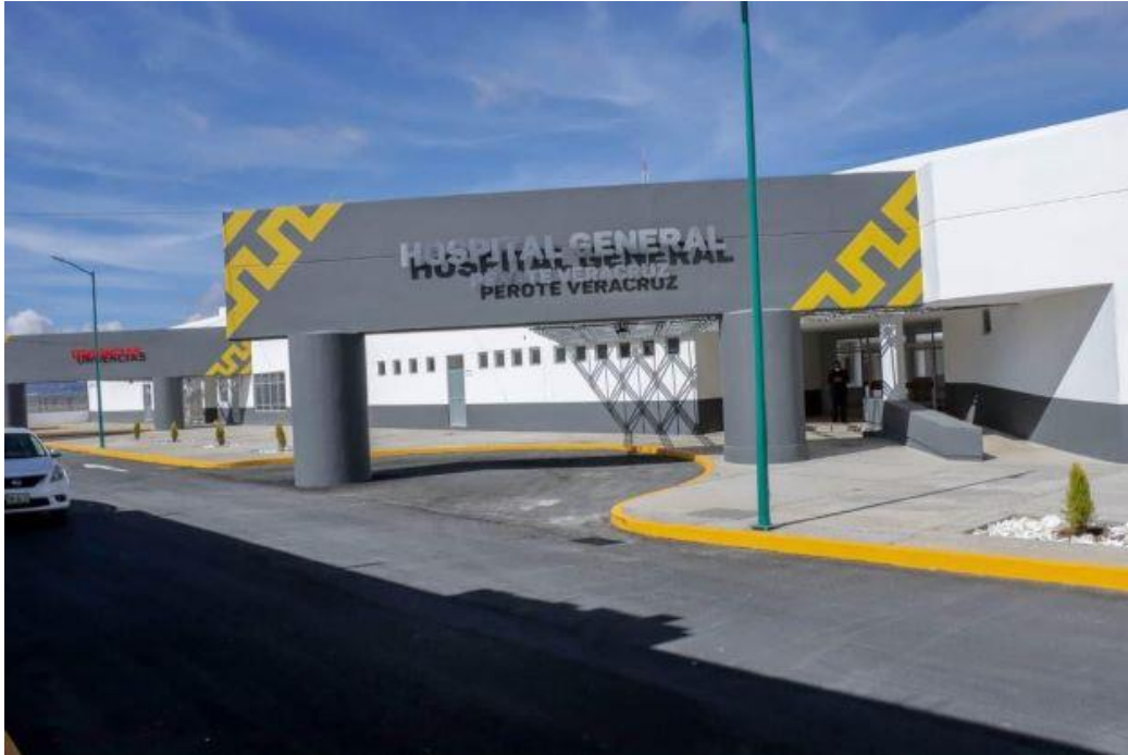
Terminación del Hospital General de Perote tras abandono de 8 años
